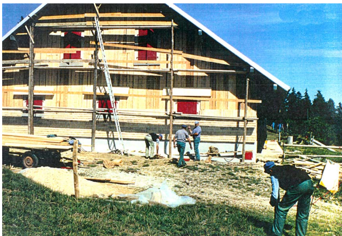
Dans les années nonante décision fut prise de tavillonner la façade à vent
